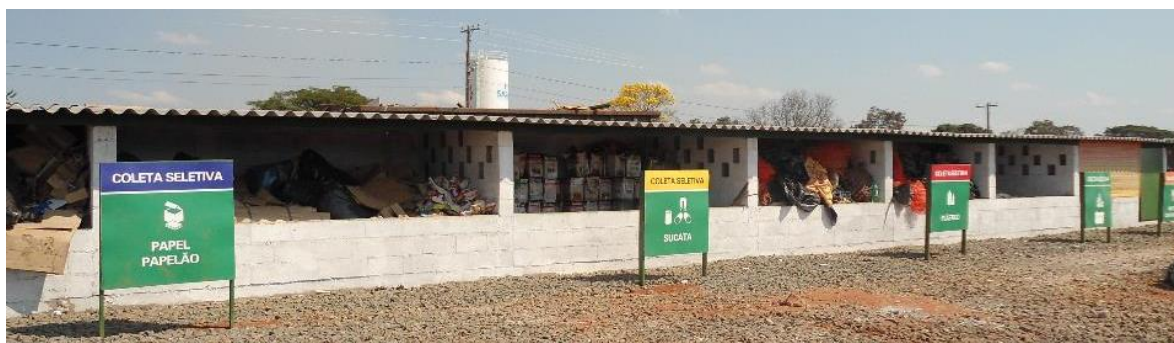
Exemplo de separação de resíduos em baias no canteiro de obras
